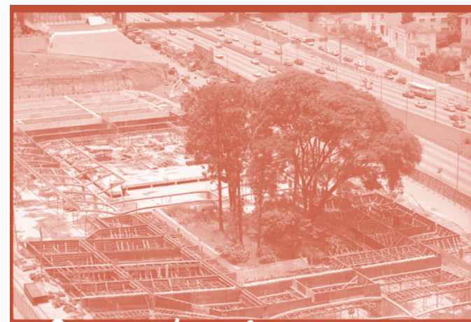
Imagens da área do Jardim Central - Luiz Telles e entorno com formas para concretagem, 1981. Fotografia Antonio Corso
